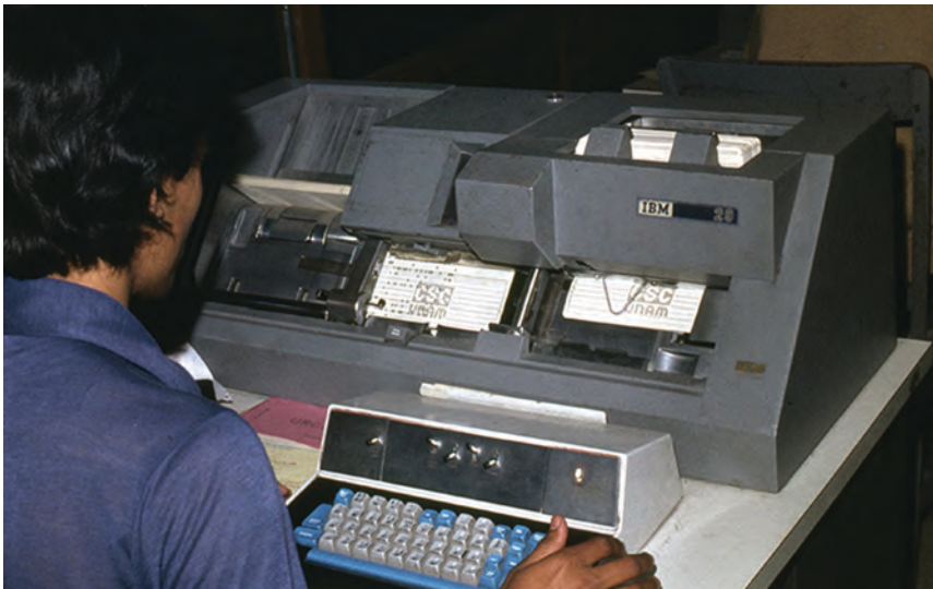
Perforadora de tarjetas IBM modelo 029, ca. 1975. UNAM. DGTIC. Historia de cómputo en México. CC BY-NC-SA ESP 3.0
